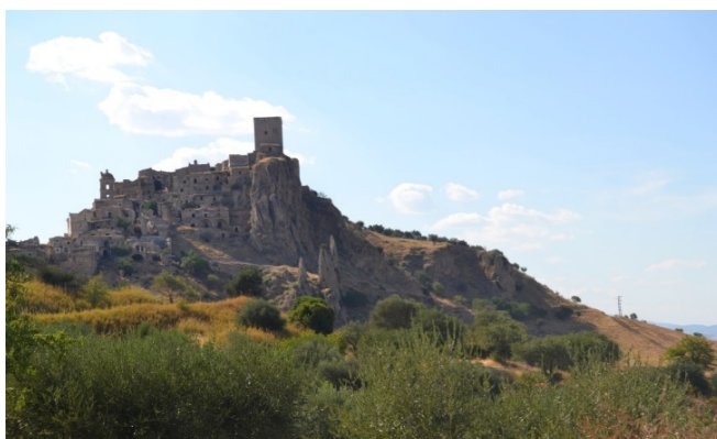
Figura 15 La fortificazione di Craco interessata da lenti fenomeni di frana riconducibili a espandimenti laterali e a ribaltamenti.
